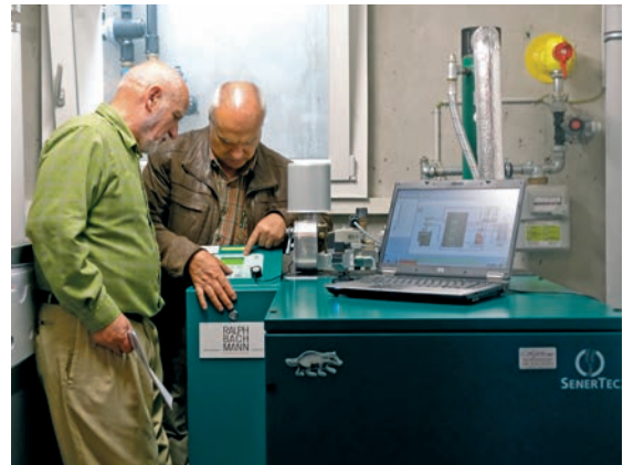
Bild 5: BHKW mit einer Leistung von 5 kW el und 14 kW th
