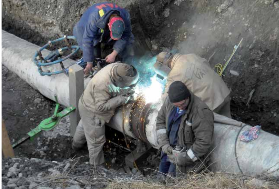
Die Ölleitung im St. Galler Rheintal wird zur Erdgas-Hochdruckleitung umgebaut.
