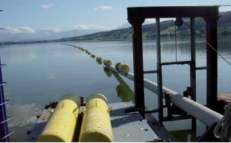
Bau der Erdgas-Leitung durch den Baldeggersee nach Hitzkirch LU.
